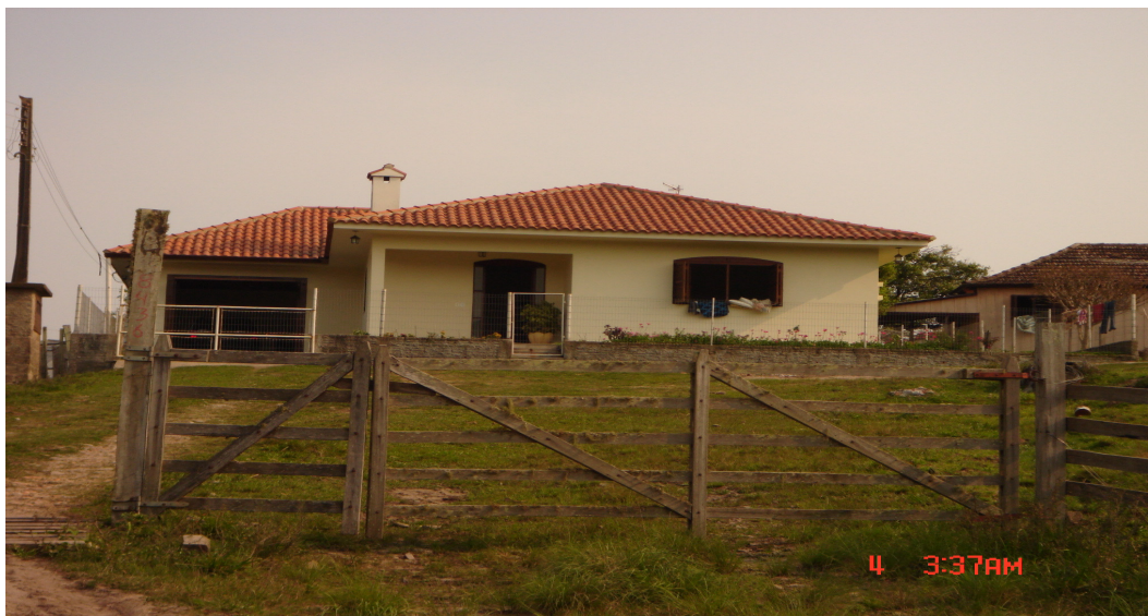
Fotografia14: Melhoria no padrão de vida a partir das moradias, distrito Santa Flora, 2008.
