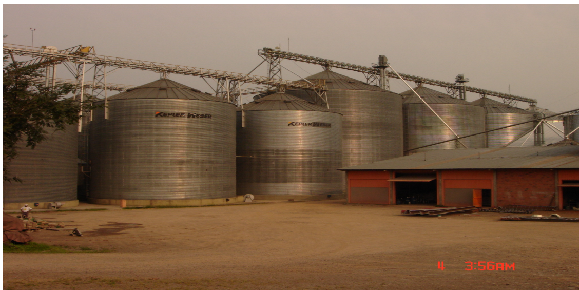
Fotografia 7: Vista parcial dos silos de armazenagem de arroz. 2008.
