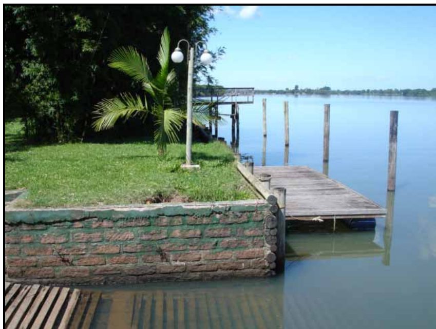
Figura 16 - Aterramento na margem do Rio.
