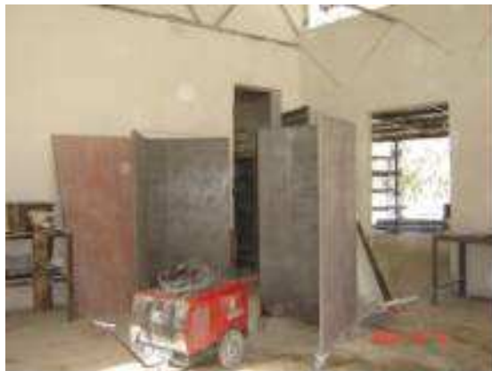
Figura 05– Biombos de Proteção para Soldadores
