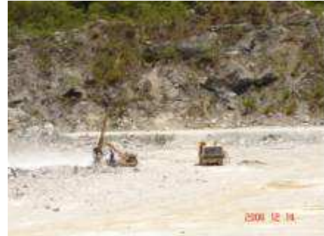
Figura 03 – Perfuratriz e Compressor Diesel
