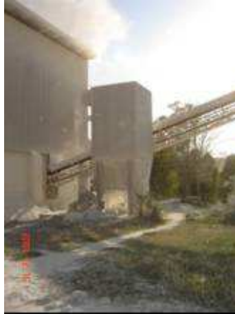
Figura 09 – Controle de emissão de poeira através de captadores tipo filtro manga
