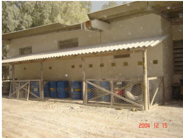
Figura 14 – Depósito de líquidos inflamáveis
