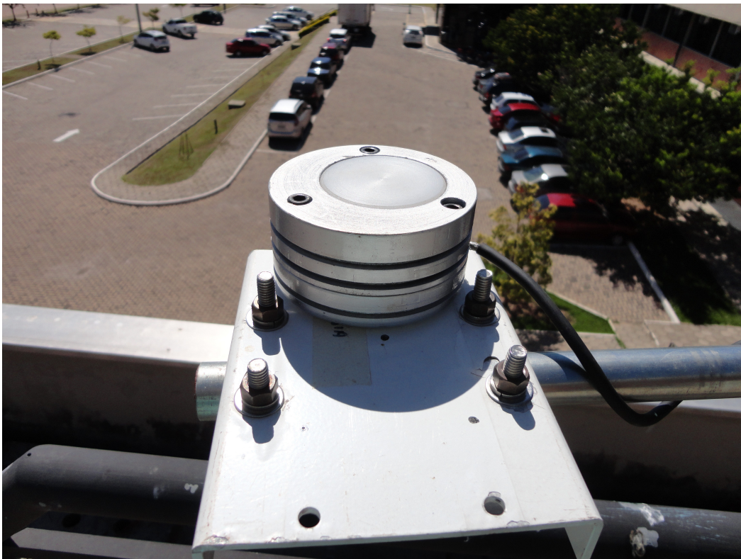
Figura 15 – Corpo do protótipo pintado e já instalado no local de testes.
