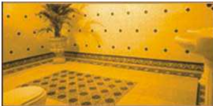
Exemplo de piso com tapete e rodapé de ladrilhos hidráulicos.
