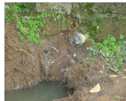
Falta de coleta de esgotos
