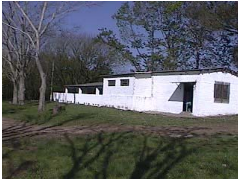
Figura 01 - Vista externa da sala de digestibilidade e metabolismo
