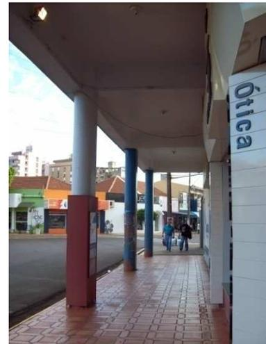
Figura 45: Edifício Lithon Lanes Pilau, projeção dos pavimentos superiores sobre o passeio. Fonte: A autora, 2010.
