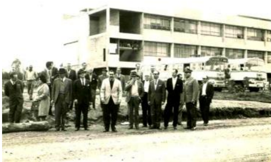
Figura 110 - Visita às obras do Campus da UFSM, década de 1960 63 Fonte: Acervo particular de JMRF
