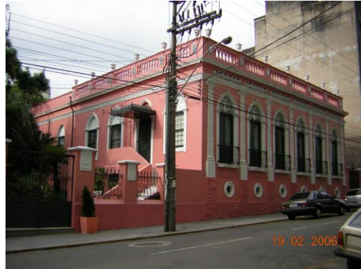
Figura 10 - Foto atual da casa
