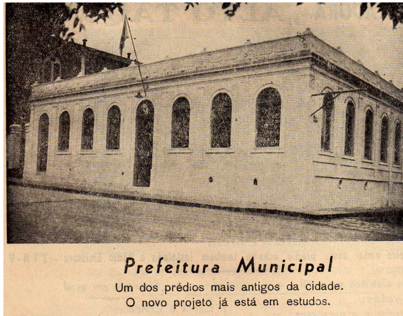
(Fotografia 23) Antiga Intendência municipal. Detalhe: “Um novo projeto já está em estudos”.
