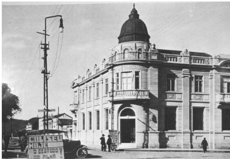
Prédio do Banco Pelotense.
