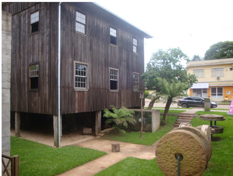
Figura 32 – Pátio entre as edificações do conjunto. Sob o Moinho situa-se o porão. Fonte: Acervo da autora, 2010.
