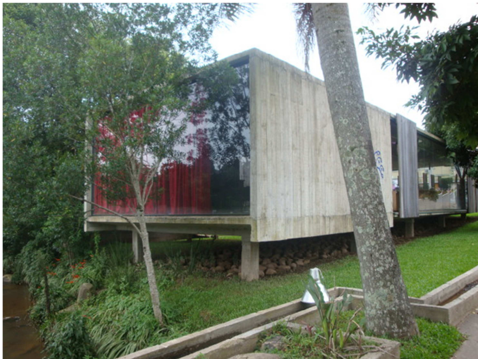
Figura 18 – No detalhe a canaleta circundando o Conjunto Arquitetônico Museu do Pão – vista sul.
