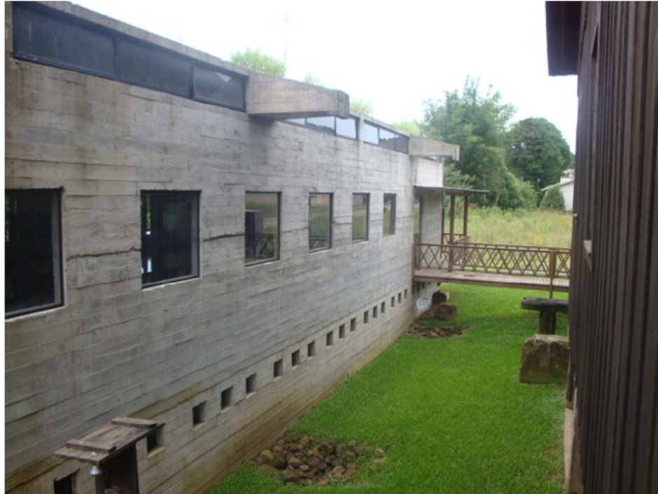
Figura 31 – Dupla fileira de janelas na Oficina de Panificação. Fonte: Acervo da autora, 2010.
