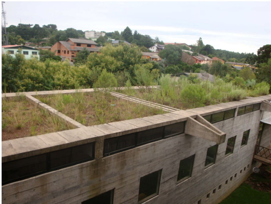
Figura 34 – Telhado verde sobre a Oficina de Panificação. Fonte: Acervo da autora, 2010.
