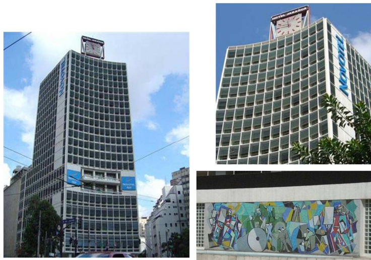
Figura 3 - Fotos do Hotel Jaraguá após as obras de Retrofit . Fonte: Alvarez, p. 19, 2007.
