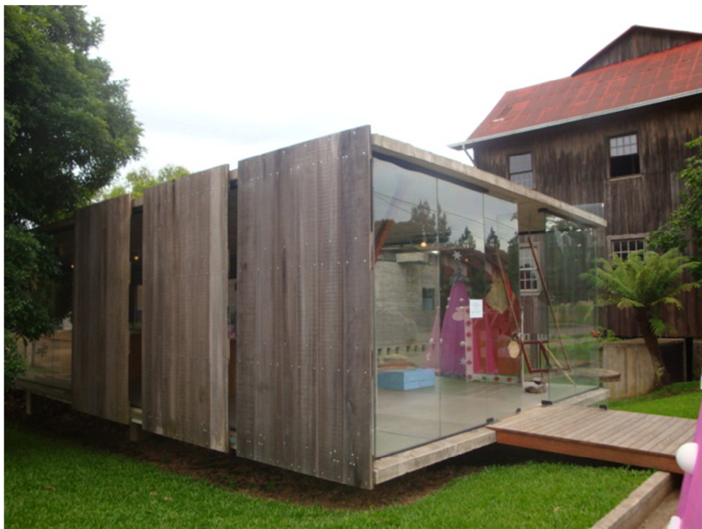
Figura 29 – Painéis móveis na fachada do edifício do Museu do Pão. Fonte: Acervo da autora, 2010.
