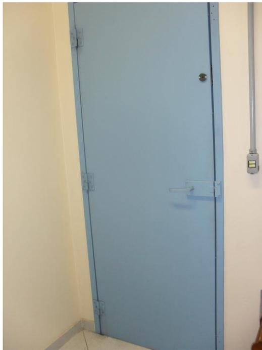
**FIGURA 6: Porta corta fogo e fiação elétrica do Arquivo de Segurança**
