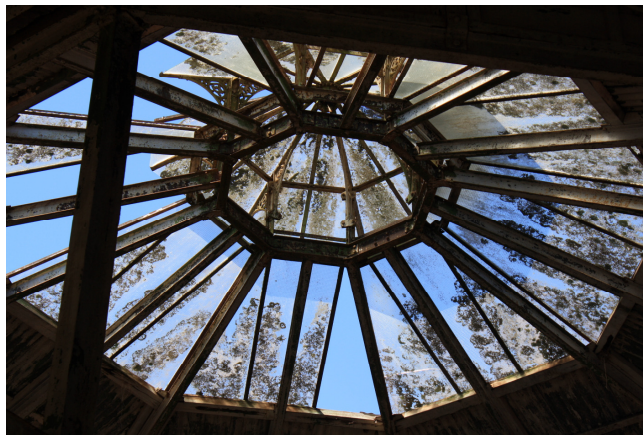
Figura 75 – Detalhe da clara-boa metálica encontrada na parte central do edifício. Fonte: Arquivo pessoal, 2012.
