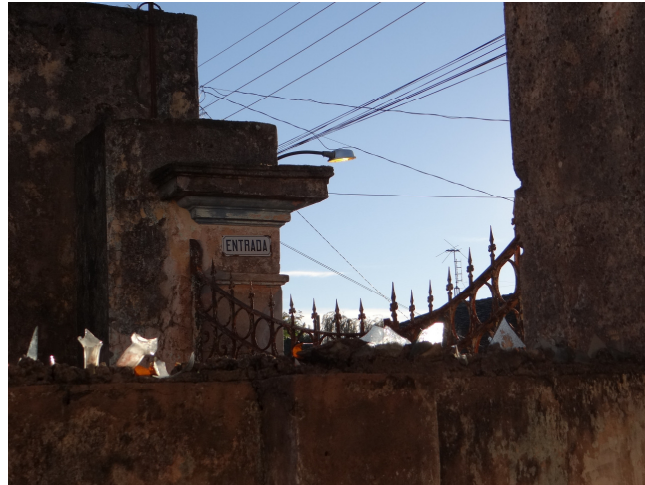
Figura 39 – Fachada Leste -Detalhe placa entrada da Rua das Carroças. Fonte: Arquivo pessoal, 2012.
