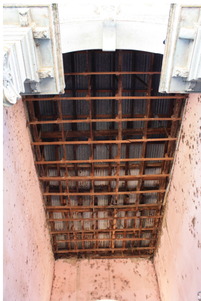
Figura 73 – Imagem do acesso principal sem a presença de forro. Fonte: Arquivo pessoal, 2012.
