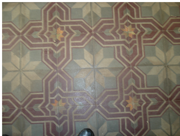
Figura 69 – Detalhe do piso original, ladrilho hidráulico. Fonte: Arquivo pessoal, 2011.
