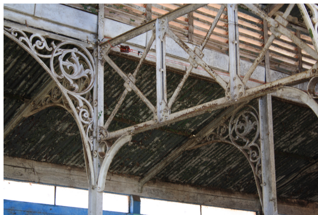
Figura 60 – Imagem atual do estado de conservação da estrutura central do edifício. Fonte: Arquivo pessoal, 2012.
