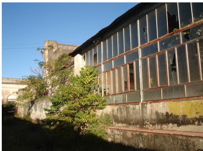
Figura 54 – Imagem atual do fechamento da área central, fundos do Mercado Público. Fonte: Arquivo pessoal, 2012.
