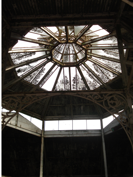
Figura 42 – Imagem interna da área central em estrutura metálica e vidro. Fonte: Arquivo pessoal, 2012.
