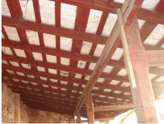
Figura 74 – Detalhe cobertura junto a galeria. Fonte: Arquivo pessoal, 2012.
