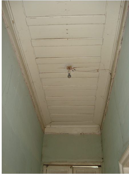
Figura 71 – Detalhe do forro ainda original de madeira. Fonte: Arquivo pessoal, 2011.
