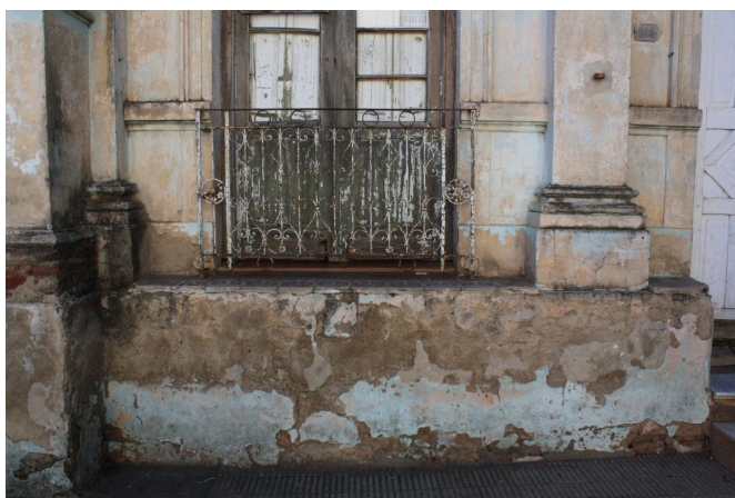
Figura 59 – Imagem atual do estado de conservação da parede externa, onde se pode visualizar as cores utilizadas. Fonte: Arquivo pessoal, 2012.
