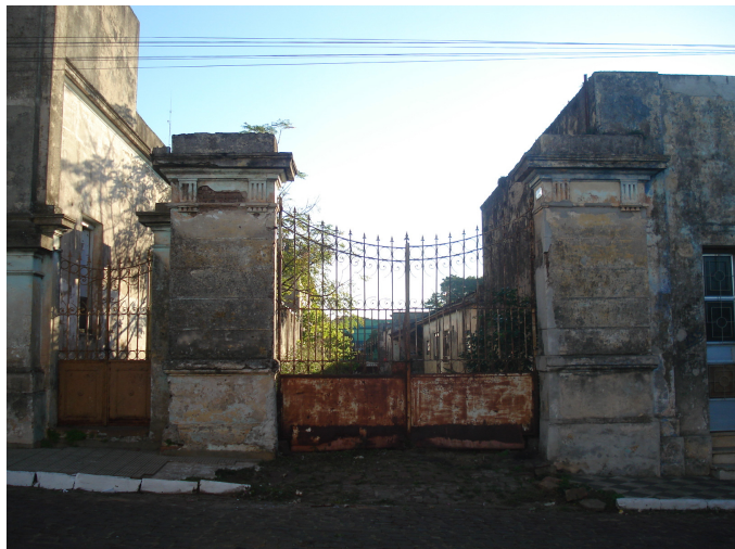
Figura 49 – Imagem da lateral da edificação através do Travessa Domingos Lacroix. Fonte: Arquivo pessoal, 2012.
