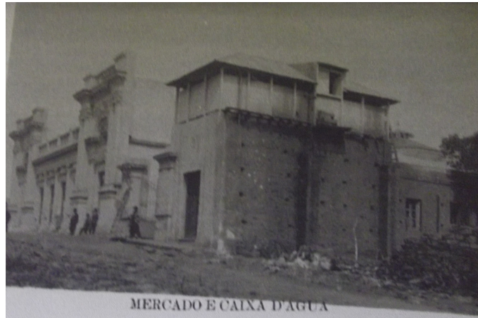
Figura 52 – Imagem da caixa d'água instalada na lateral da edificação do Mercado Público, voltado para a Travessa domingos Lacroix.
