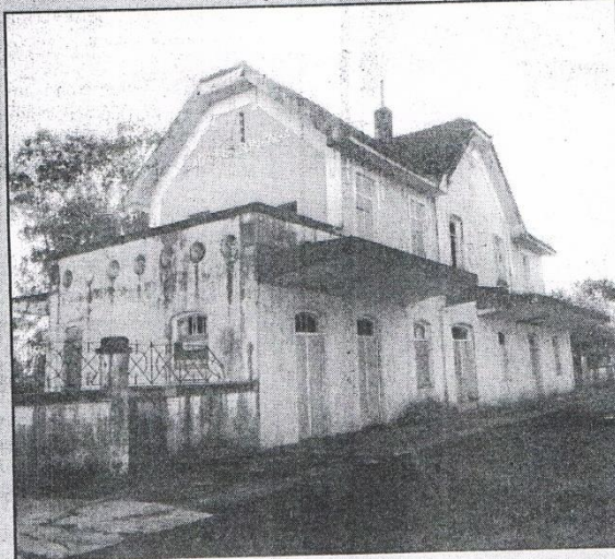
A situação do prédio onde funcionou a Estação Férrea de São Luiz Gonzaga
