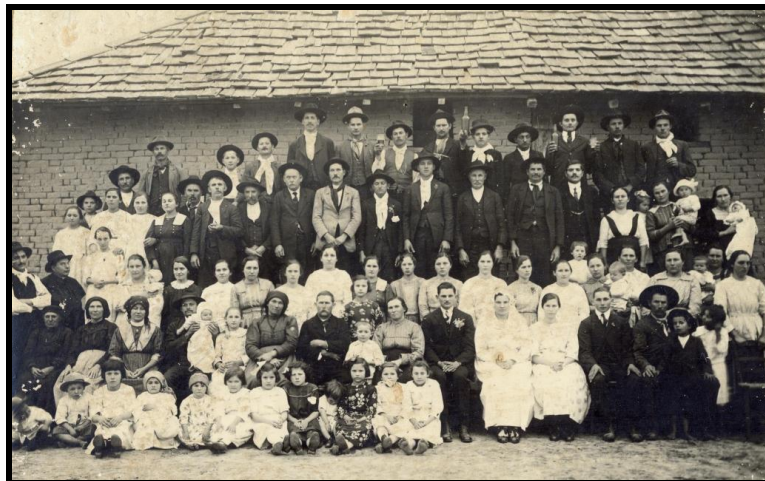
Figura 88 – Telhado feito com tabuinhas de madeira chamadas “scandoles”- 1920
