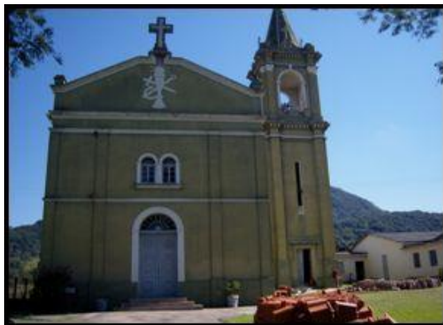
Figura 40 – Capela São Pedro em Ribeirão
