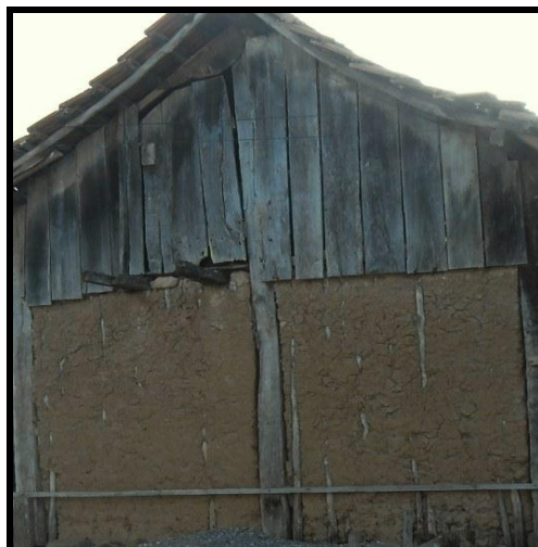
Figura 137 – Primitiva casa da família Dotto com parede revestida de barro
