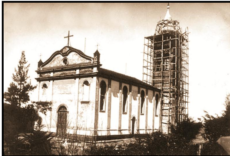
Figura 30 – Construção da Torre em 1921 - Vale Vêneto
