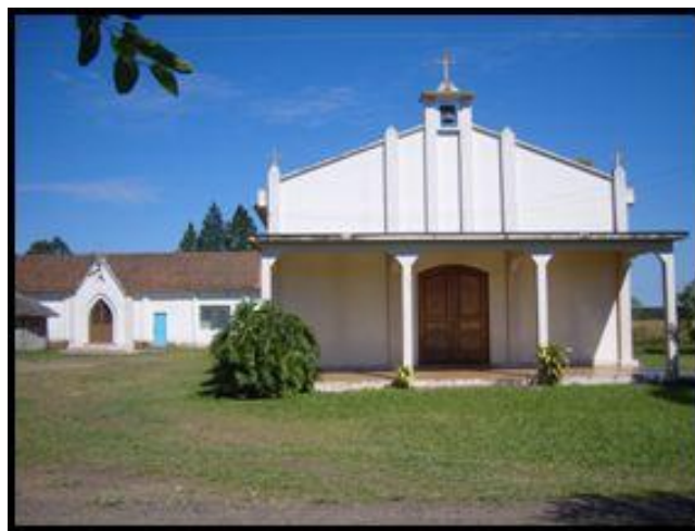
Figura 45 – Capela Nossa Senhora Aparecida
