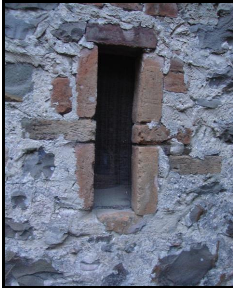
Figura 138 – Arquitetura do séc XIX. Janela para ventilação do porão.
