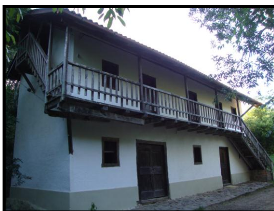
Figura 141 – Acesso a parte superior da residência de 1882. Vale Vêneto
