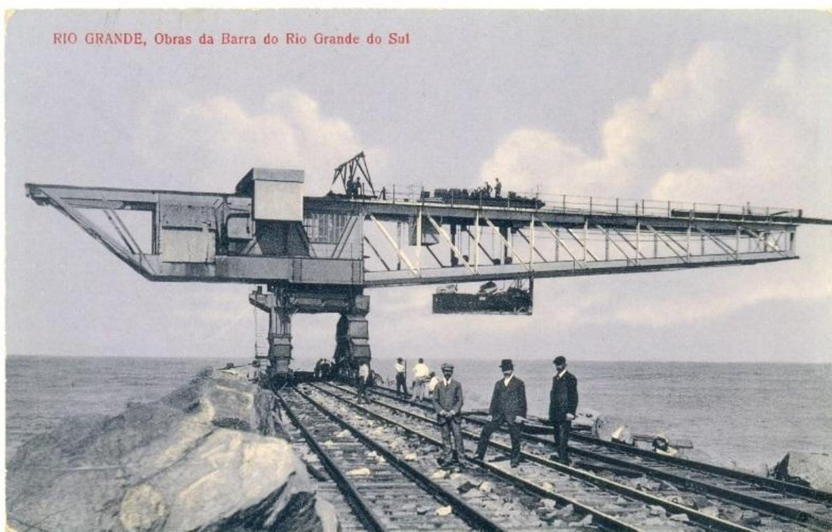
**IMAGEM 18** – Construção dos Molhes da Barra
