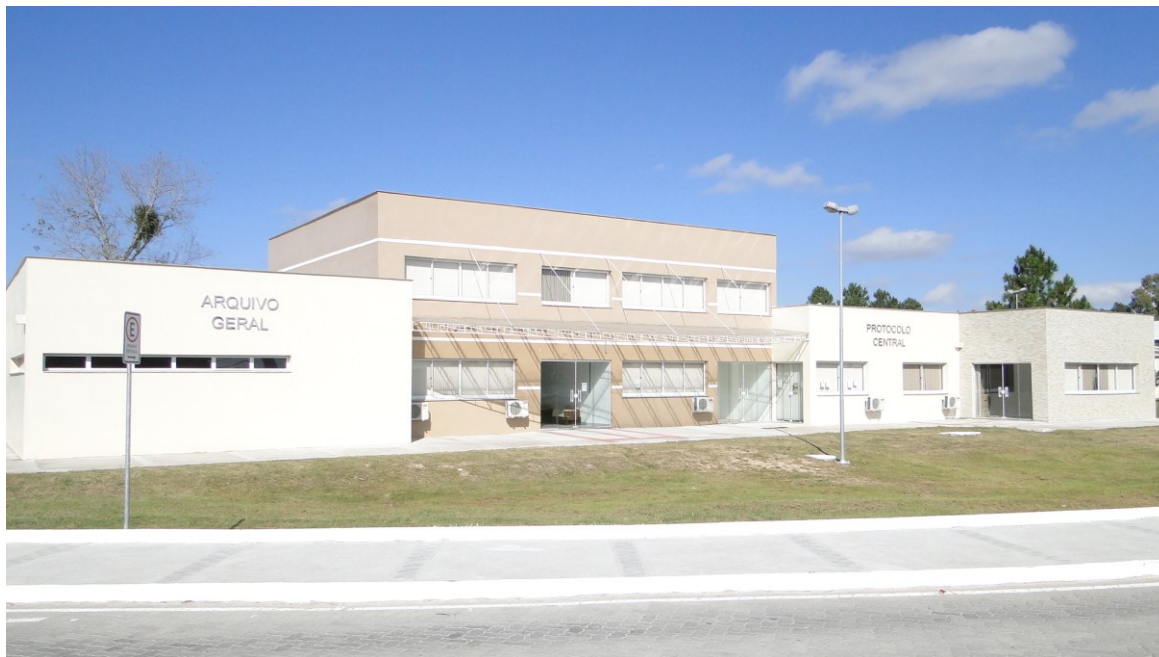
Imagem 10 : Fase de finalização do prédio da Coordenação de Arquivo Geral
