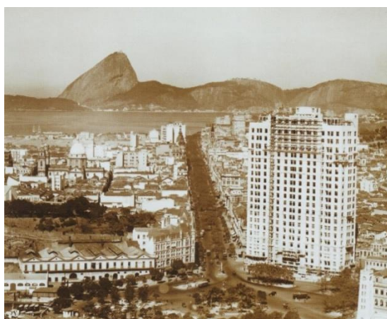
Figura 35: Com 102 metros de altura, o Edifício “A Noite” se destacava na paisagem carioca de 1929. Fonte: GIRAUD, 2012.
