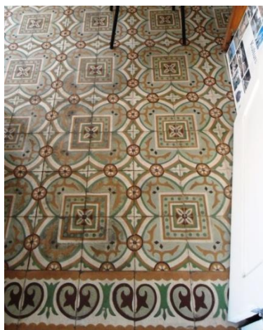
Figura 27 - Piso de revestimento em ladrilho hidráulico e objeto decorativo do período Art Déco .
