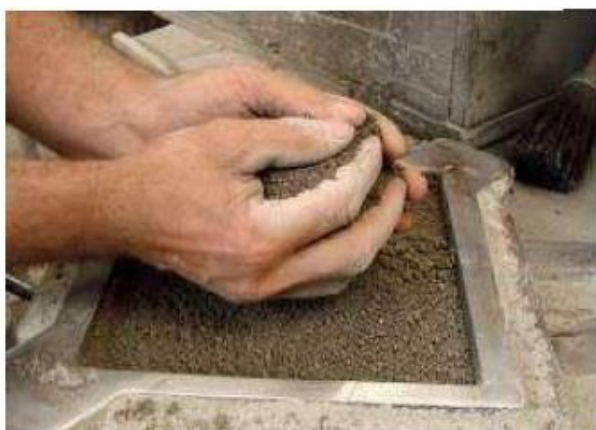
Figuras 65 e 66 - Colocação e regularização da argamassa base. Fonte: CAMPOS, 2011, p. 65.
