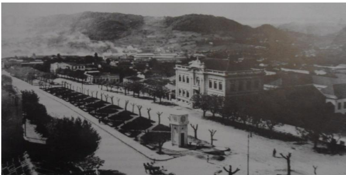
Figura 3 - Rio branco com a caixa d'água construída para irrigar seus canteiros em 1925.
