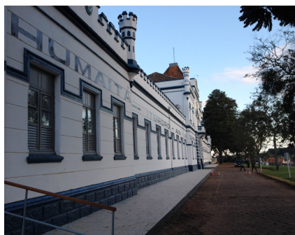
Figura 4: Exemplos de algumas aberturas presentes nas edificações. Fonte: Acervo do Autor, 2015
