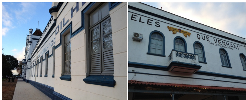
Figura 105 - Exemplos de algumas aberturas presentes nas edificações
