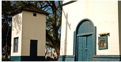
Torre do reservatório e casa de máquinas Angelo Roque
