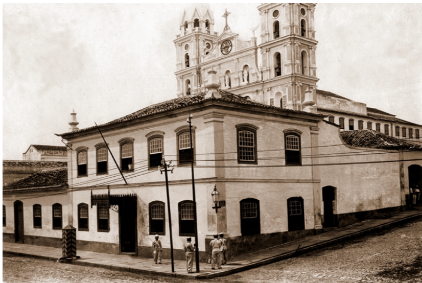
Figura 11 - Edificação colonial que abrigava as funções do Quartel General anteriormente
