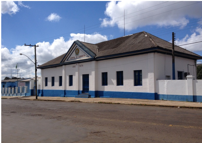
Figura 23 - Vista da fachada principal do atual Posto Médico de Guarnição de Cruz Alta
