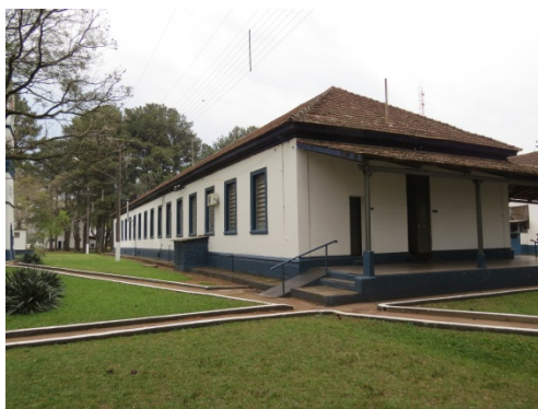
Figura 50 - Vista lateral da edificação
