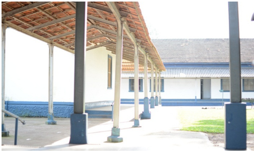
Figura 94 - Vista de uma varanda de ligação entre os edifícios
