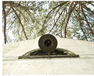
Detalhe da luminária presente na fachada Angelo Roque
