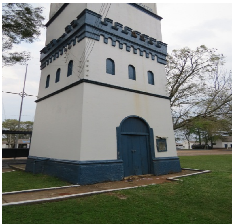
Figura 104 - Vista da porta de acesso a área interna do reservatório
