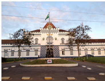
Figura 1: Vista da elevação frontal da edificação frontal. Fonte: Acervo do autor, 2014.
