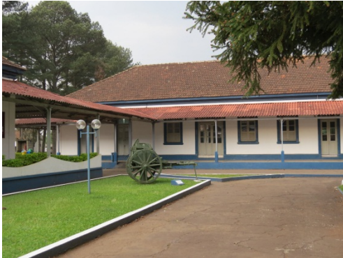
Figura 55 - Vista da elevação frontal da edificação
