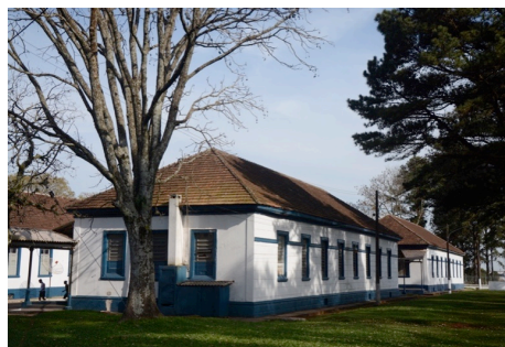
Figura 6: Vista de uma tipologia construtiva presente no conjunto arquitetônico. Fonte: Acervo do autor, 2015.
