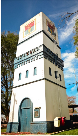
Torre do reservatório Angelo Roque
