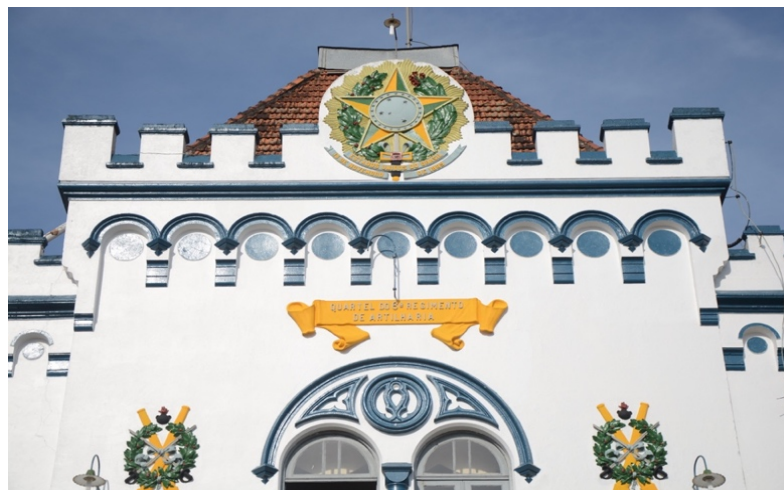
Figura 91 - Vista da platibanda existente na tipologia T1
