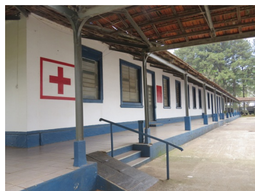
Figura 51 - Vista frontal da edificação
