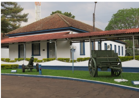
Figura 36 - Vista frontal de uma das edificações
