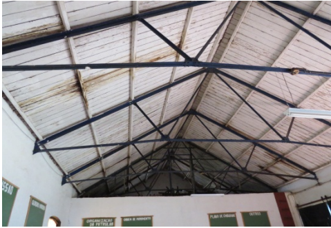
Figura 63 - Estrutura metálica de sustentação do telhado
