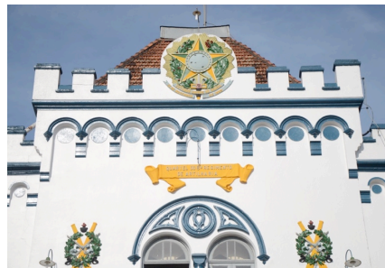
Figura 2: Vista da platibanda frontal. Fonte: Acervo do autor, 2015.
