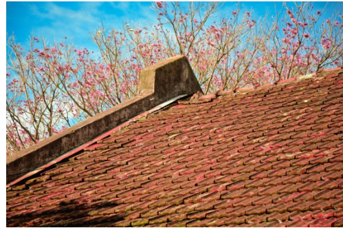
Figura 64 - Detalhe do oitão lateral visto a partir do telhado
