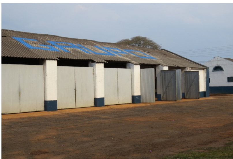
Figura 100 - Vista da atual garagem das viaturas
