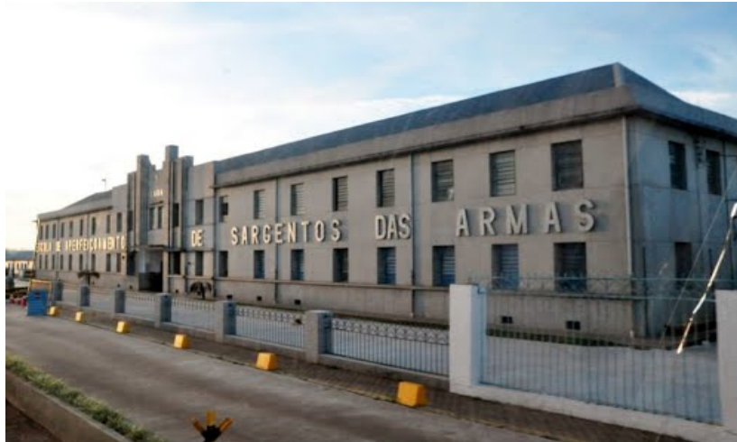
Figura 19 - Vista atual da edificação principal da EASA
