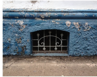
Vista da gateira presente nas edificações Mateus Veronese
