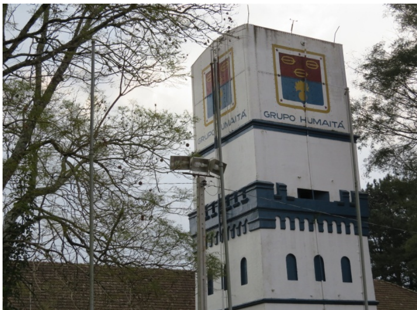
Figura 103 - Vista do reservatório superior
