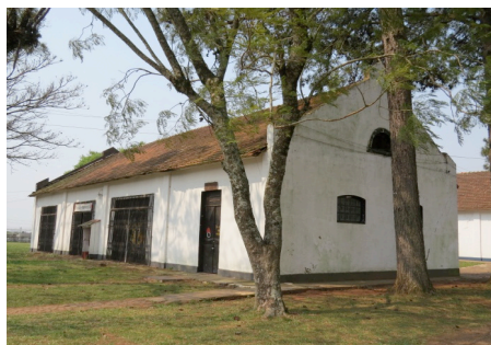
Figura 5: Vista de uma tipologia construtiva presente no conjunto arquitetônico. Fonte: Acervo do autor, 2014.
