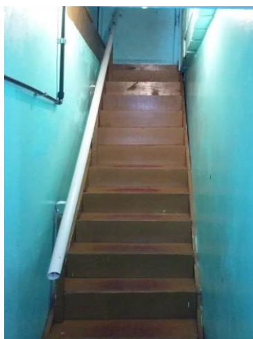
Imagem 6 Escada que dá acesso à parte inferior do prédio
