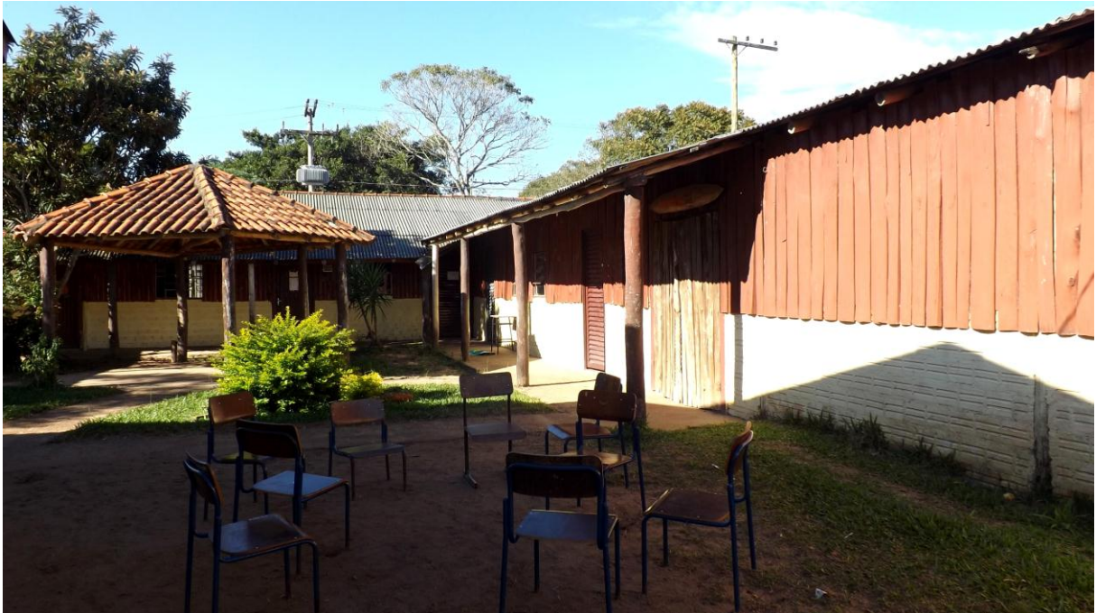
Figura 08 - Prédio da década de 1970 que foi interditado. Fonte: Alecsandra Cunha – junho/2014.
