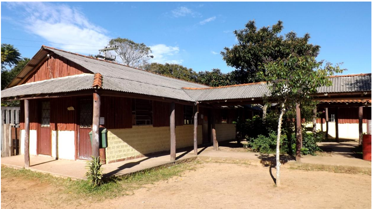
Figura 07 – Prédio da década de 1970 que foi interditado. Fonte: Alecsandra Cunha – junho/2014.
