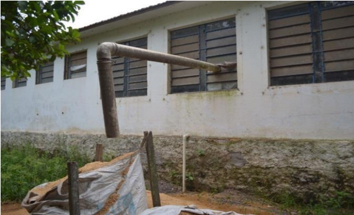
Figura 22 - Uso Atual do Prédio: Beneficiamento de Arroz.
