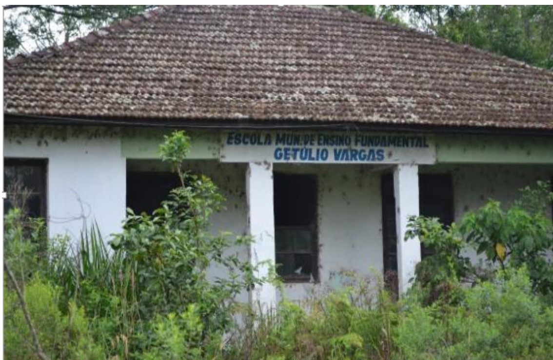
Figura 32 – Penúltima Escola Municipal E.F.I Desativada: Getúlio Vargas.
