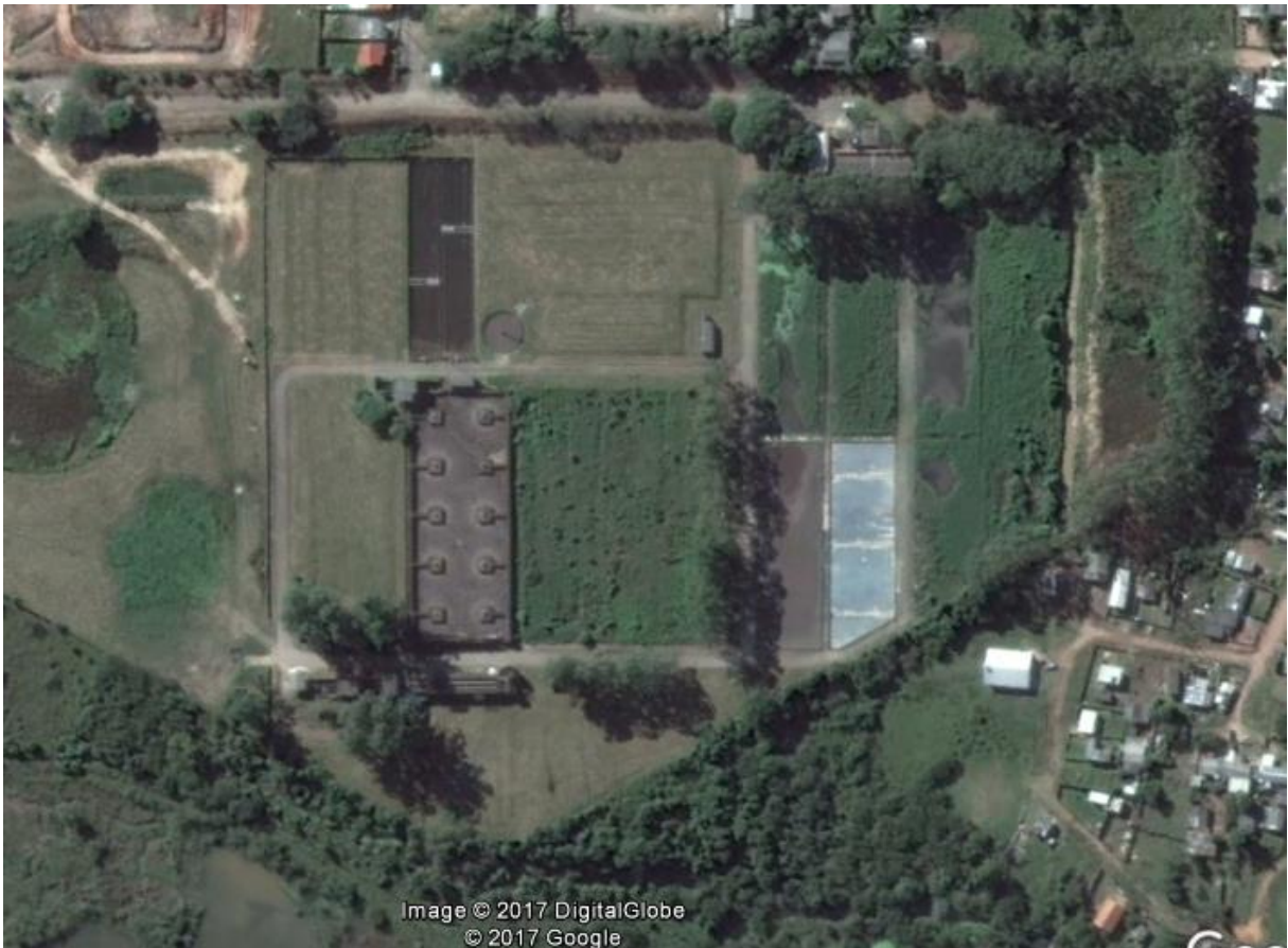
Figura 5 - Vista da Estação de Tratamento de Esgoto de Santa Maria – RS
