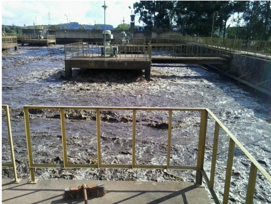
Figura 1 - Tanque de aerção da Estação de Tratamento de Esgoto de Santa Maria
