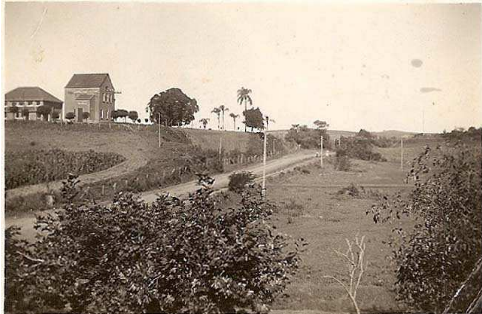
FIGURA 5 - a hidráulica velha em foto de ca. 1937 Fonte: AHS
