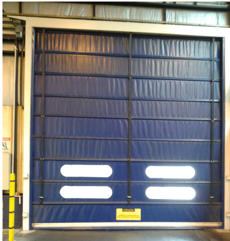
Figura 5 – Porta Rápida Um localizada no acesso ao setor de pré-moldado.
