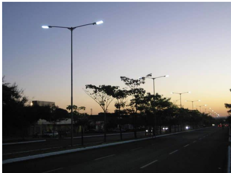
Figura 6 - Disposição dos BBE LU6 – High Power LED na Avenida LO-19 de Palmas
