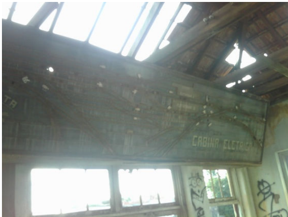
Figura 4 Quadro elétrico desativado cabine no pátio da Estação de Cruz Alta- 2011 Fonte: autora
