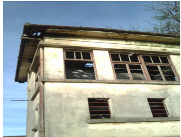
Figura 5 Prédio que abrigava a antiga Cabine elétrica na Estação de Cruz Alta- 2011 Fonte: autora
