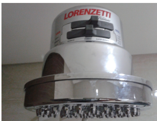
Figura 02 – Imagem do chuveiro elétrico utilizado na residência estudada.
