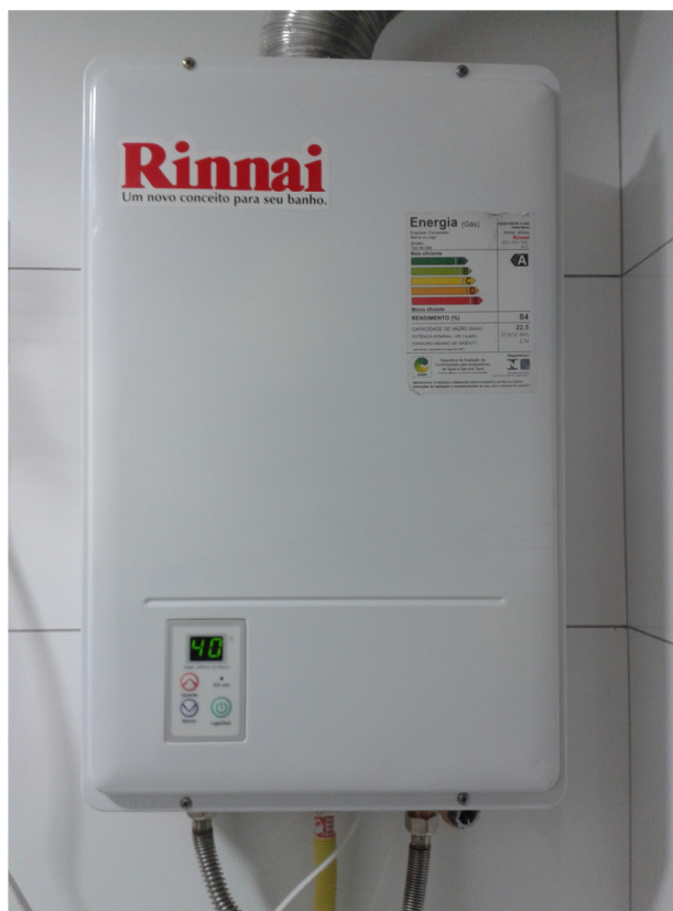
Figura 03 – Imagem do aquecedor de passagem a gás utilizado na residência estudada.
