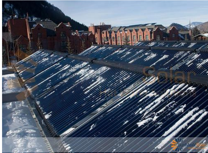
Figura 17 – Fotografia de sistema de tubos a vácuo
