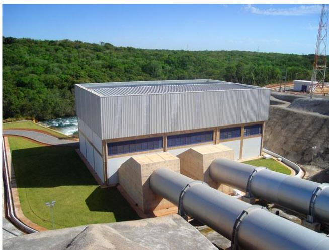
Figura 09 – Conduto Forçado – PCH Garganta da Jararaca – Rio do Sangue – MT
