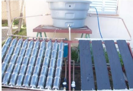
Figura 15 - Instalação e disposição dos coletores solar de baixo custo Fonte: Corrêa; Sá (2012)
