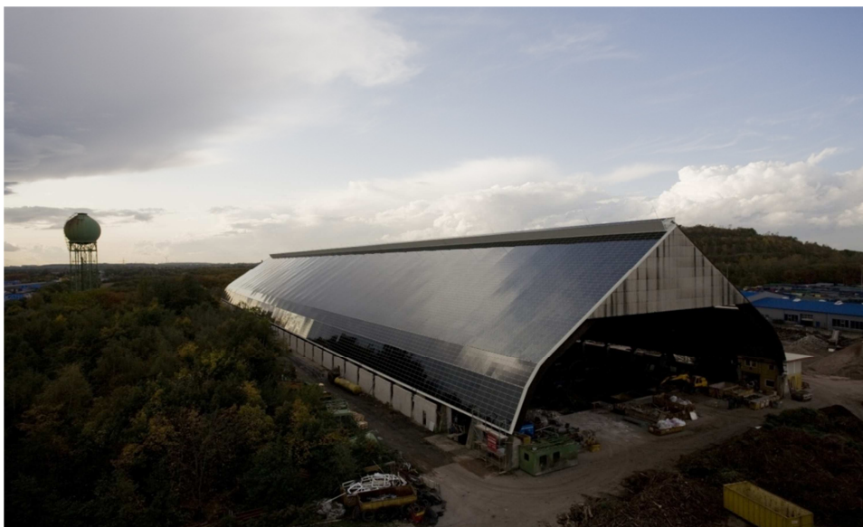
Figura 1 – Aplicação de células fotovoltaicas em galpão. (Fonte: http://www.bipv.ch/index.php/en/industrial-s-en/item/596-riede )
