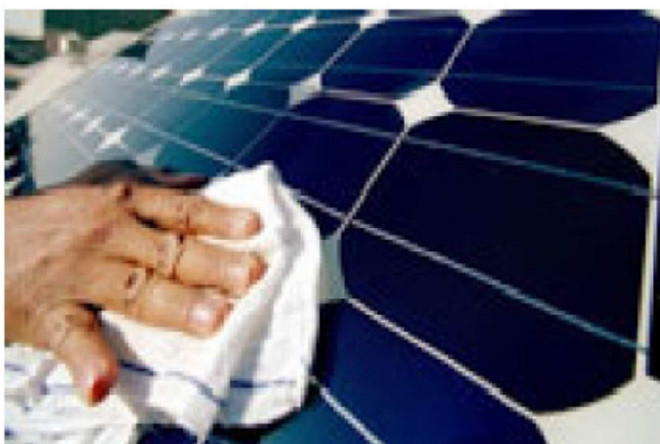
Figura 31 – Limpeza dos módulos fotovoltaicos. (Fonte: TORRES, 2009)
