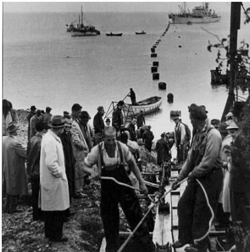
Figura 1: Fotos da obra da primeira aplicação Comercial em HVDC
