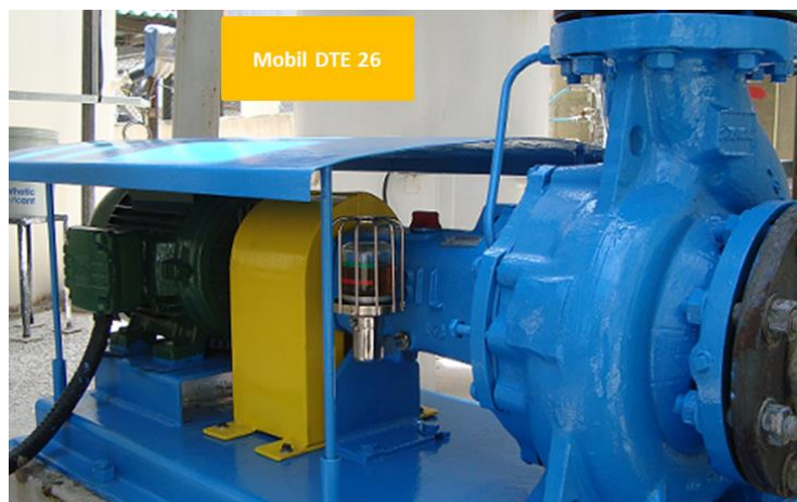
Figura 17 – Vista da Bomba d’água após as melhorias individuais e instalação de visualizadores de óleo.
