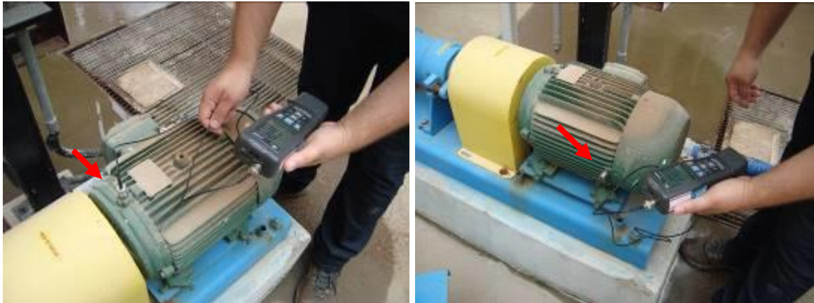
Figura 6 – Medição da vibração dos motores elétricos.
