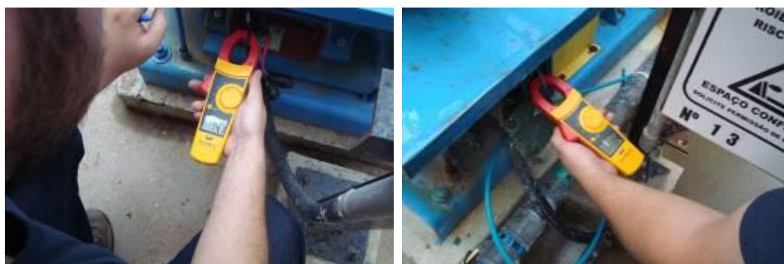
Figura 8 – Realização de medições de corrente dos motores elétricos das bombas BCC1 e BCC2.
