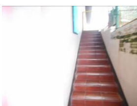
Escada na EMEI-b.
