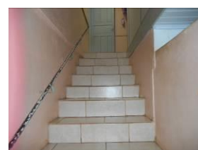
Escada na EMEI-b
