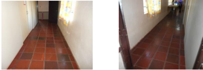
Corredor ao lado da sala da EMEI-b, o qual dá acesso ao refeitório.
