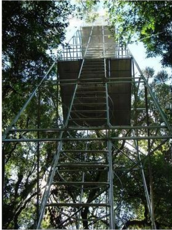
Figura 3.1 – Torre micrometeorologica do sitio de São João do Triunfo.
