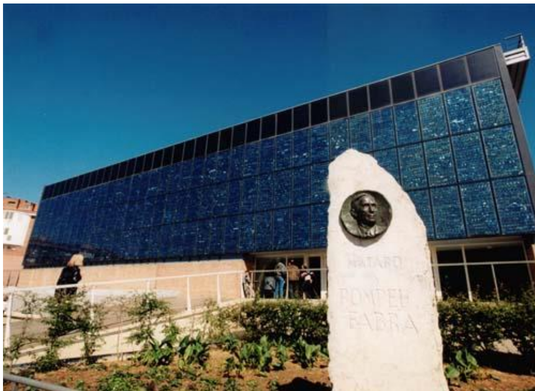
Figura 4- Fachada com módulos fotovoltaicos da Biblioteca Pompeu Fabras, Catalunya, Espanha.
