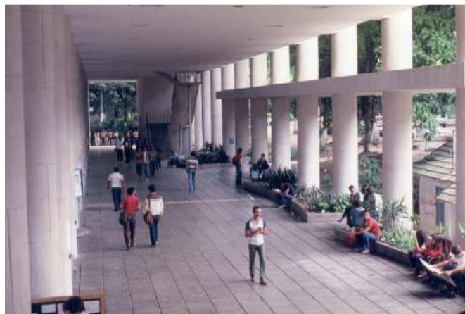
Figura 08 – Edifício Público sobre Pilotis.
