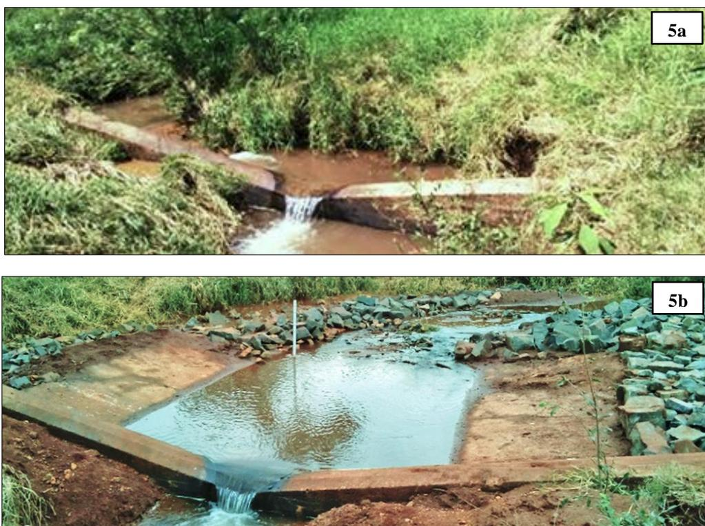
Figura 6: Vertedor triangular da bacia hidrográfica norte assoreado e com o curso d'água em desvio (6a) e em operação, desassoreado, e com taludes estabilizados por pedras (6b).
