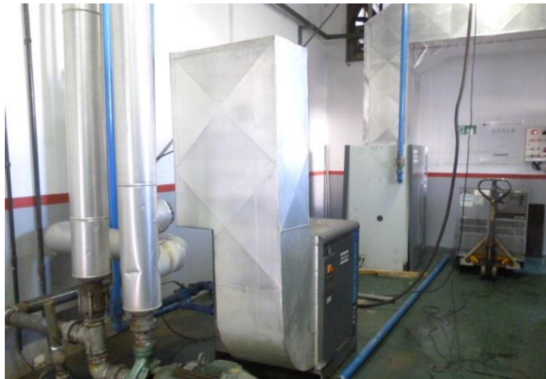
Figura 10: Posicionamento e interligações dos compressores.
