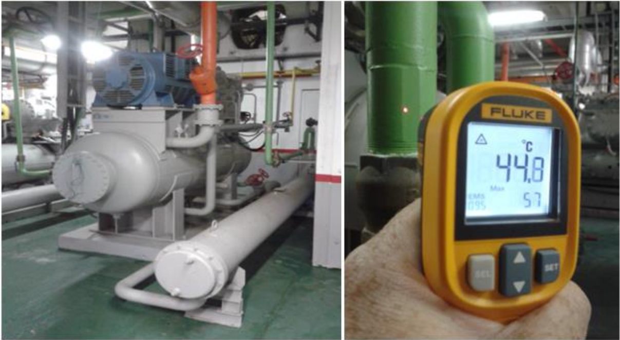
Figura 34 – Verificação de temperatura d'água no Compressor HOWDEN WRV 255 Fonte: Autoria própria do autor.
