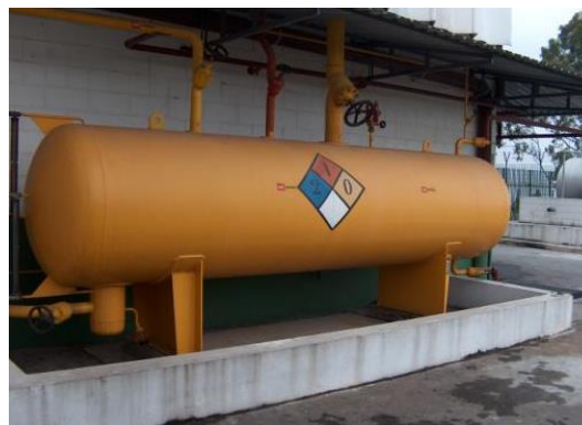
Figura 11 - Recipiente de líquido de amônia. Fonte: Produção do próprio autor.
