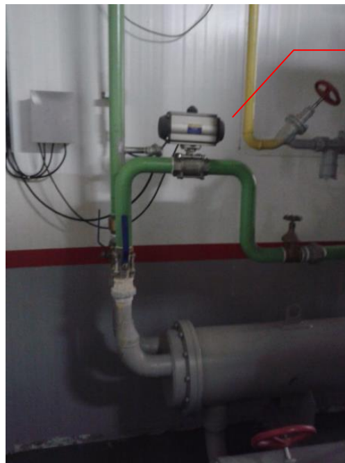
Figura 36 - Sistema controle de vazão com válvula proporcional Fonte: Autoria própria do autor.
