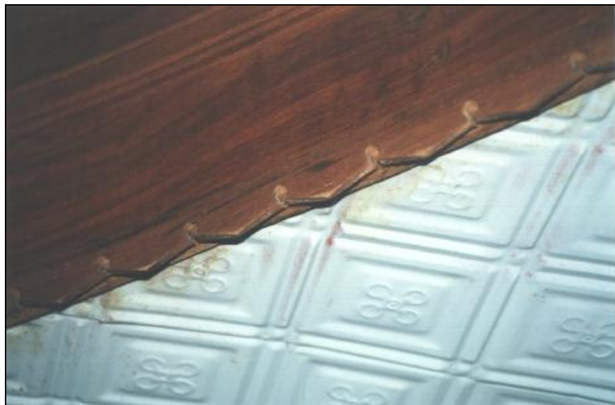
FIGURA 14 – Detalhe do guarda-corpo em madeira(2004). Fonte: Arquivo do autor.
