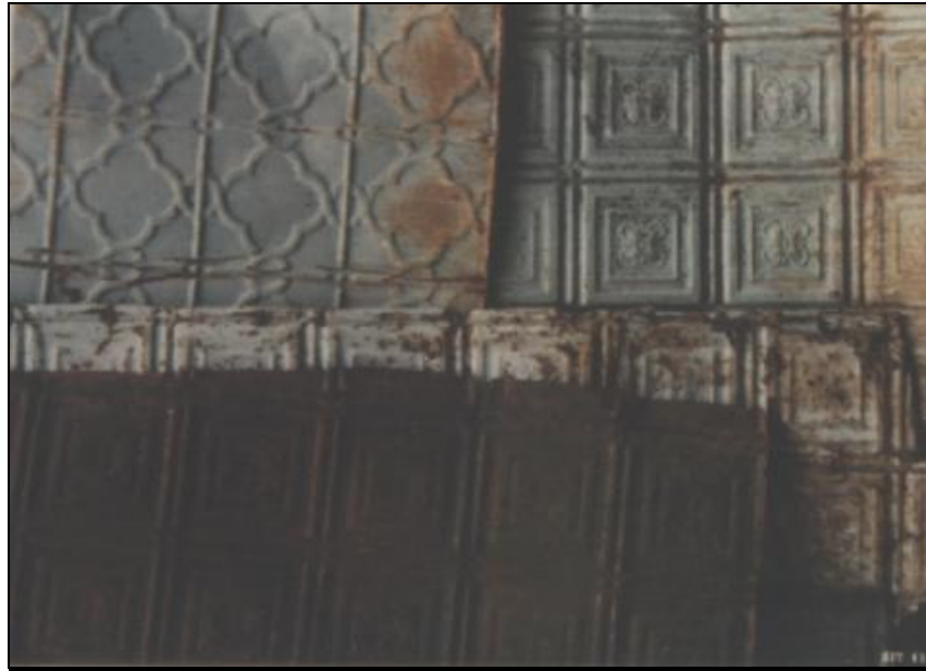
FIGURA 13 – Placas do forro original, que serviram de modelo para execução de placas novas(1983). Fonte: Arquivo do Theatro Prezewodowski
