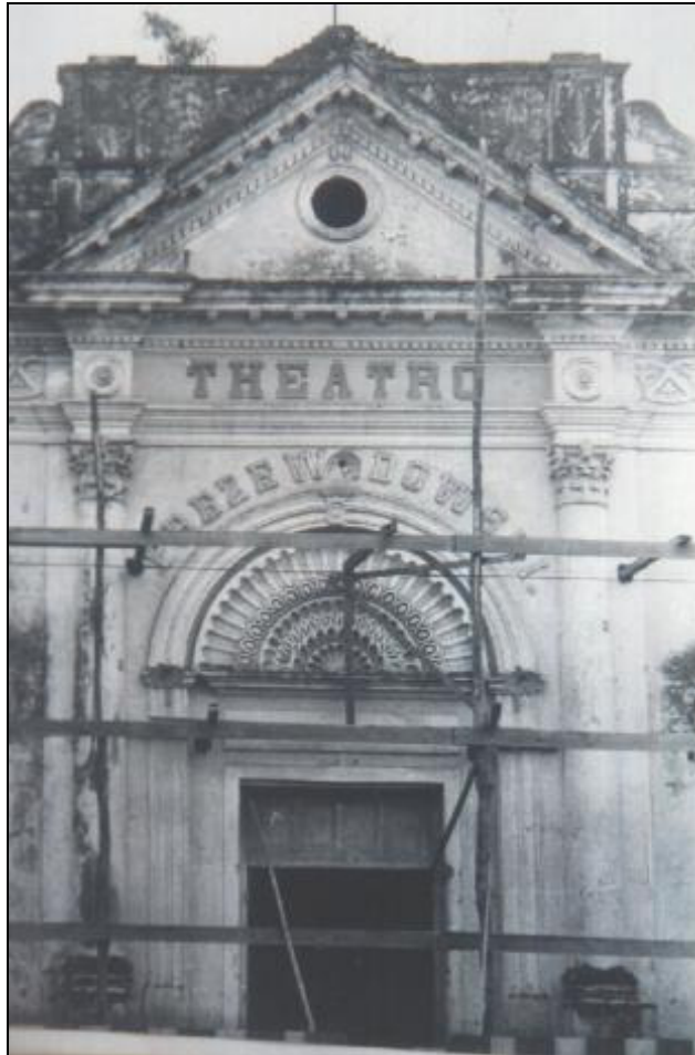
FIGURA 09 – Detalhe da fachada em 1983. Fonte: Arquivo do Teatro Prezewodowski.
