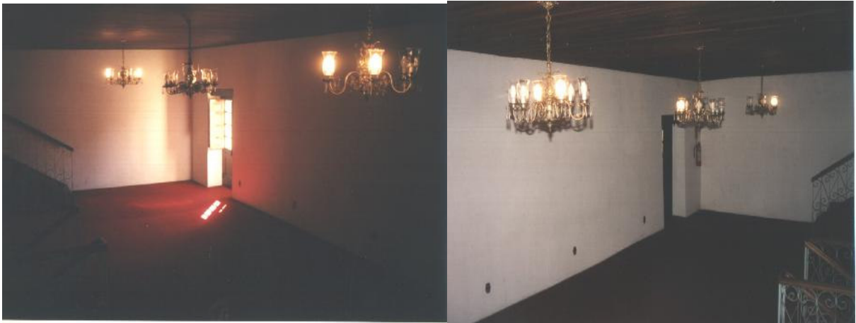
FIGURA 12- Vistas do salão Frontal, com escadas em ferro de acesso à arquibancada (2004). Fonte: Arquivo do autor.
