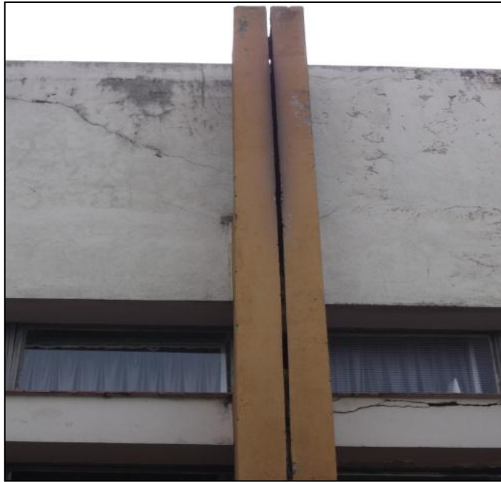
Figura 4- Junta de Dilatação do Lado Externo, Prédio 17. Fonte: Arquivo Pessoal da Autora.
