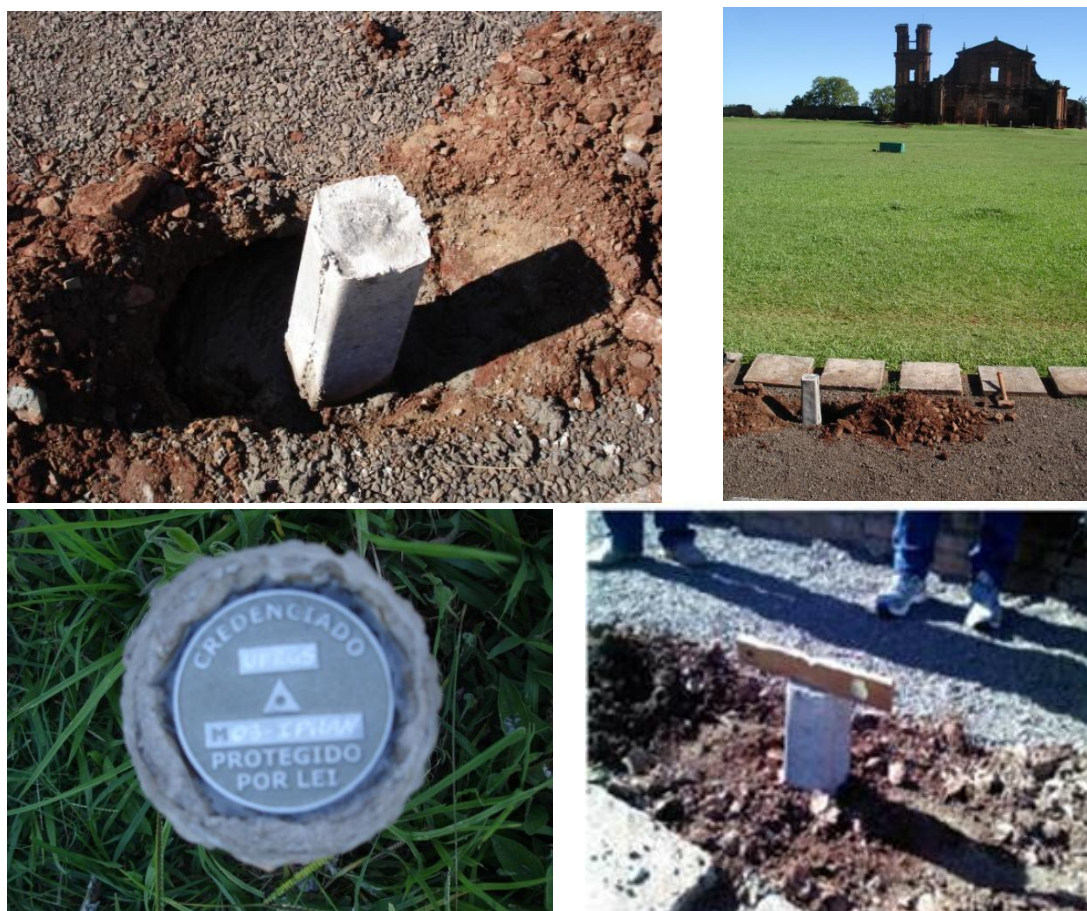
Figura 3 – Etapas de implantação da rede geodésica local
