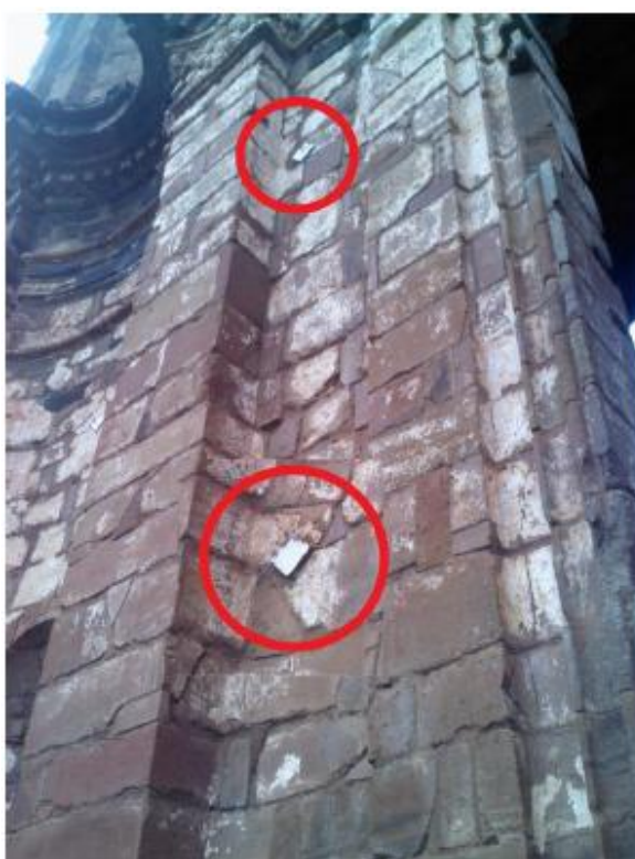
Figura 7 – Pontos existentes na fachada principal utilizados com apoio.
