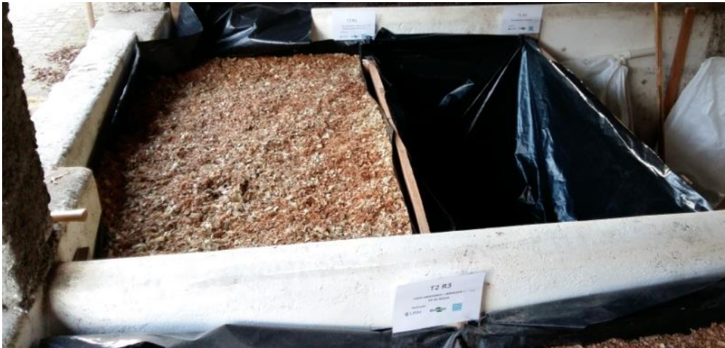
Figura 03 – Células de compostagem impermeabilizadas.
