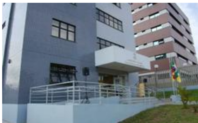
Figura 1 – Prédio Ministério Público Estadual – Promotorias de Justiça
