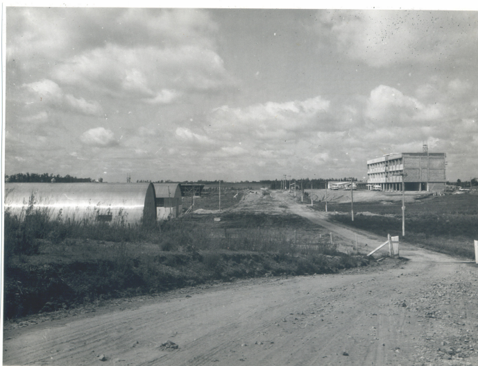
Figura 2 - Construção do prédio do Centro Politécnico
