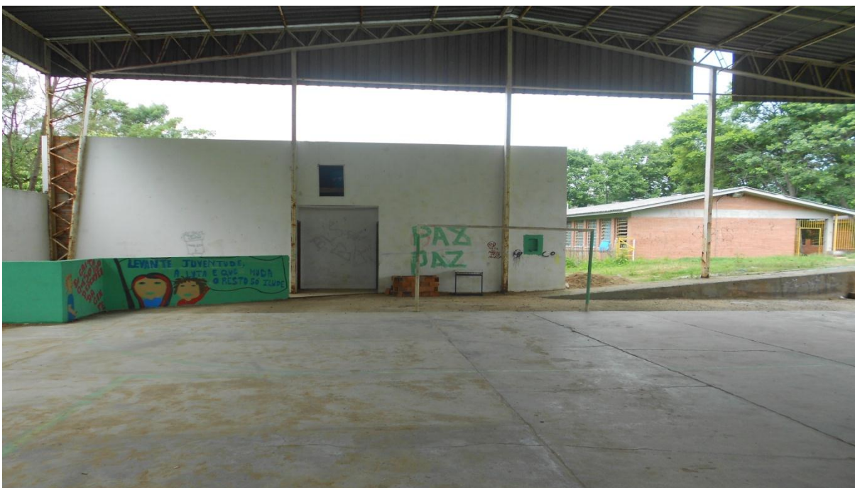
Anexo 14 – Vista da quadra poliesportiva de frente ao vestiário. Ao fundo, a direita, parte da estrutura da Escola, especificamente, das salas de aula que aparecem também na foto 8.
