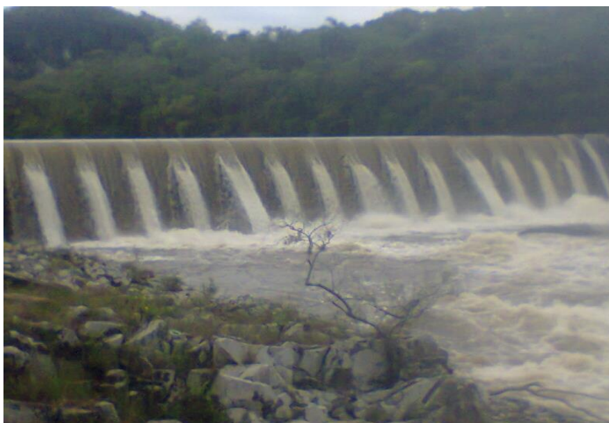
Imagem 1: Usina hidrelétrica Quebra-Dentes (1959)
